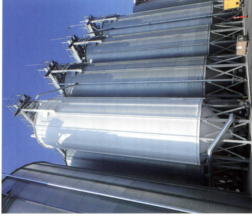
Abb. 2: Der Silo mit weißem Farbanstrich nach australischem Standard AS 2628 dient der Untersuchung im Rahmen des VSnet-Projektes zur insekten- und gasdichten Lagerung von trockenem Getreide unter den hiesigen klimatischen Bedingungen.
